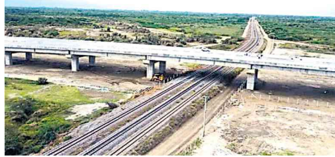
UNA VEZ SE encuentre en servicio, cerca de 1,7 millones de habitantes de 8 municipios del Caribe colombiano tendrán una vía moderna que servirá para la reactivación de la productividad de ambos departamentos.
