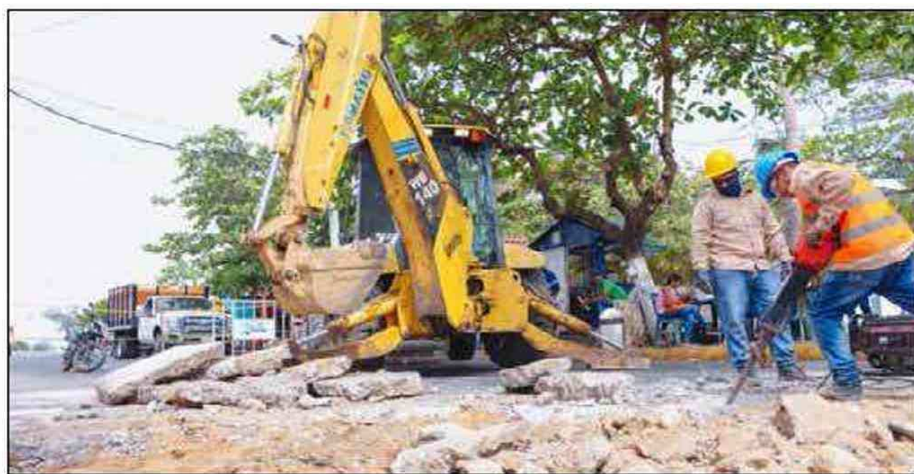
Trabajos que comenzó a realizar la administración distrital
