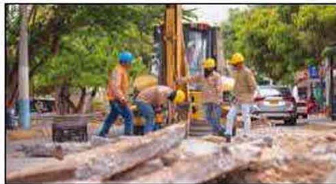
Trabajos que comenzó a realizar la administración distrital
