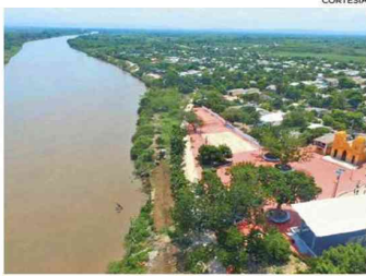
Aspecto del Canal del Dique en Santa Lucía.
