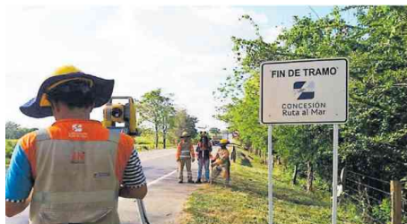
La entrega tendrá lugar en la perimetral de Tolú, vía nueva a Cartagena.
